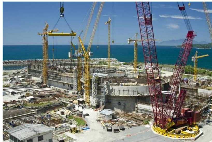
Status da construção de Angra 3 (12/ 2011) Edifício do Reator ao centro
