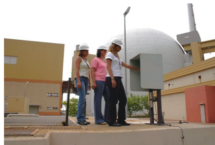
Técnicas da Eletrobras Eletronuclear durante teste em Equipamentos Elétricos
