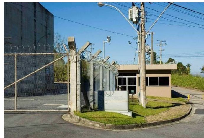
Centro de Gerenciamento de Resíduos, localizado em Itaorna
