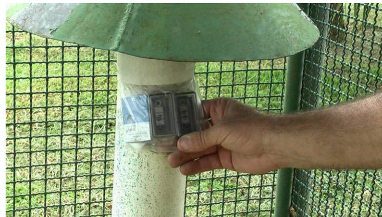
Estação de medição de Programa de Monitoramento
