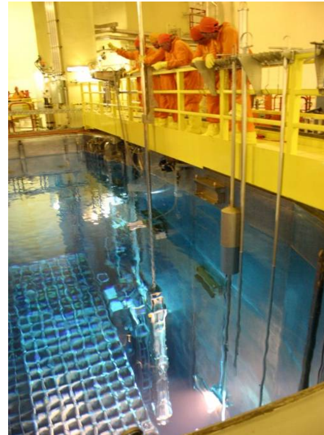
Piscina de Elemento Combustível irradiado
