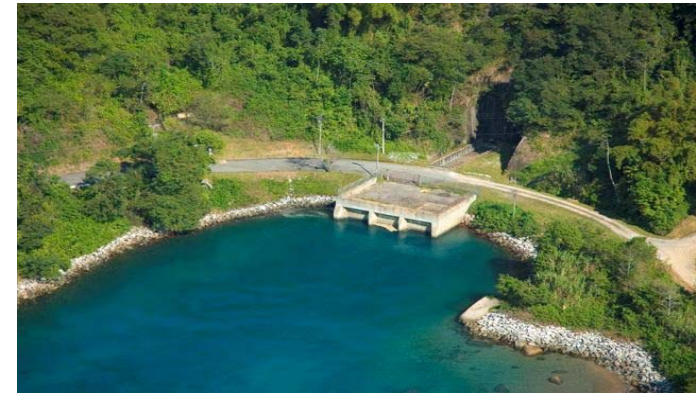
Saída da água de refrigeração dos condensadores principais de Angra 1 e Angra 2 - Saco da Piraquara de Fora
